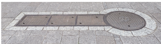
図 5.3 鉄管挿入孔とマンホール
