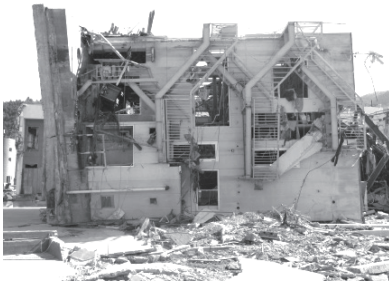
図 0.2.1-0.2.2 女川町の壊れたコンクリート建造物
