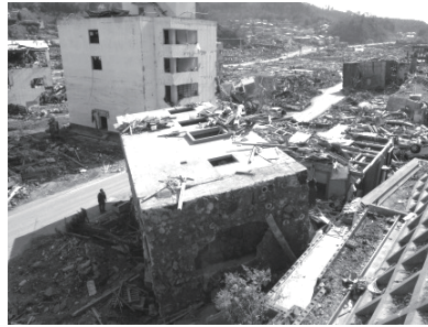
図 0.2.1-0.2.2 女川町の壊れたコンクリート建造物
